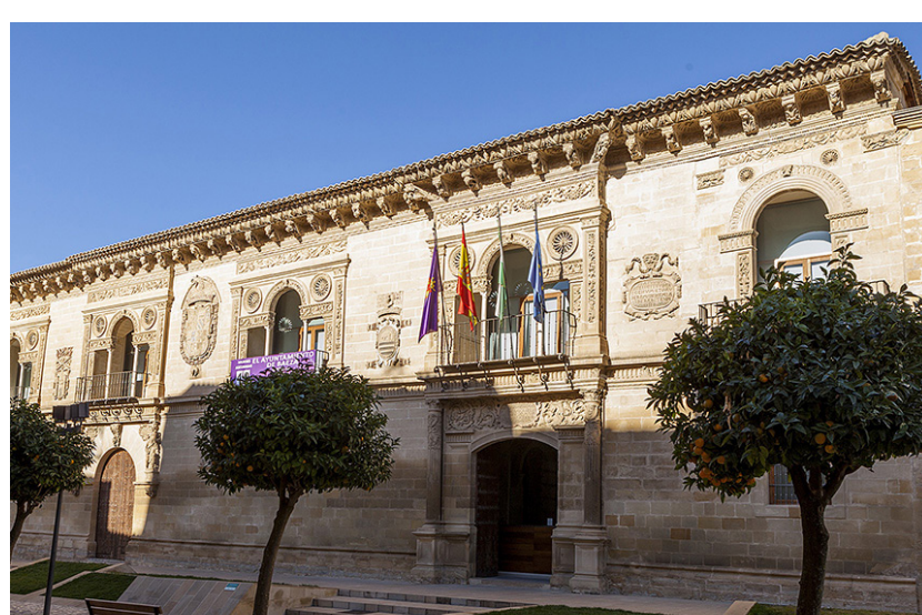
Antigua cárcel y casa del corregidor (hoy Ayuntamiento)
